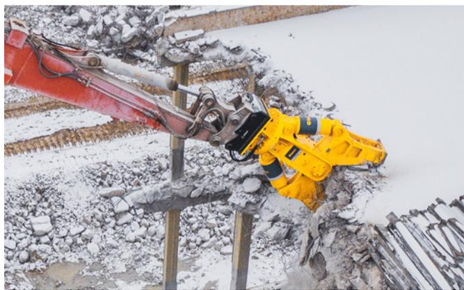
Las dos mandíbulas se mueven de forma independiente, eliminando la fuerza de desplazamiento y reduciendo los niveles de tensión.
